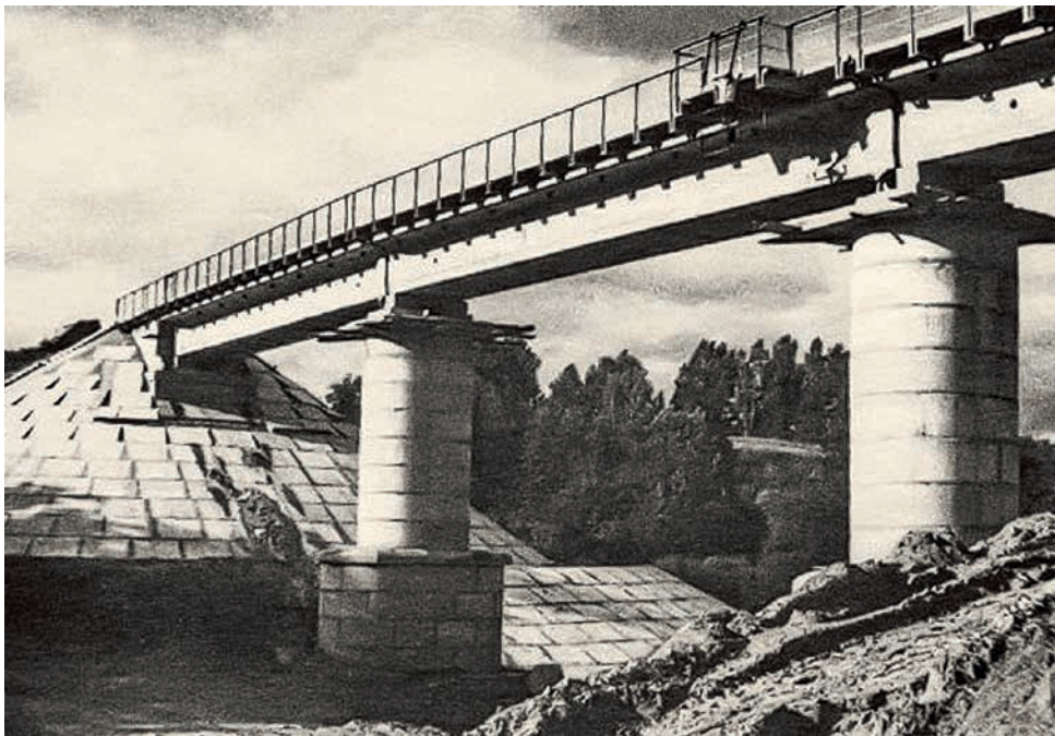
6 pav. Baigta geležinkelio žemių sankasos ir gelžbetoninio tilto per Utenėlės upelį statyba (žvelgiant iš pietų; tarp tilto taurų tolumoje matosi piliakalnio medžių guotas). 1986 m. (skaitmeninė kopija iš A. Trinkūno rinkinio)
